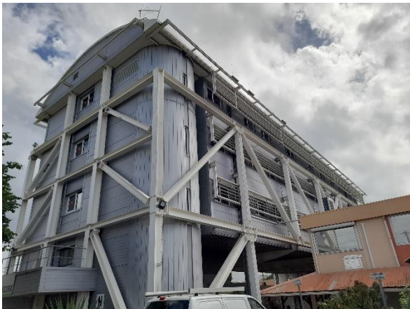
Façades Nord-Ouest et Sud-Ouest
