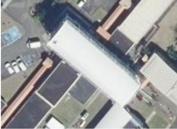
Vu aérienne de la toiture
