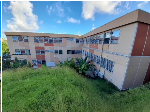
Façades Nord-Ouest et Nord-Est
