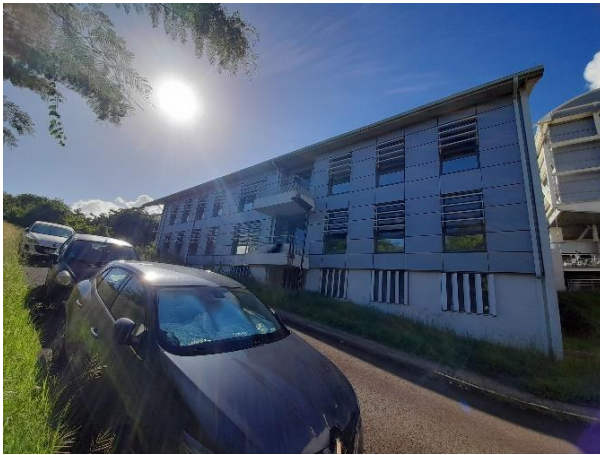
Bâtiment H (Sud-Est)
